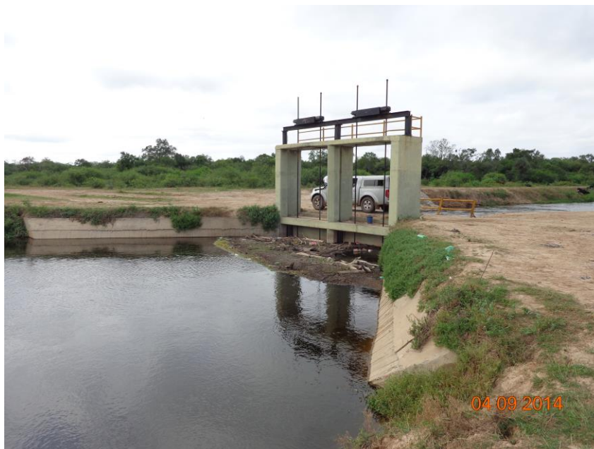
Foto 35. Aguas arriba – Vertedero
