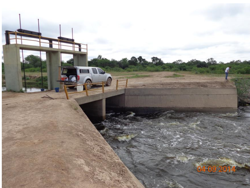
Foto 36. Aguas abajo – Vertedero
