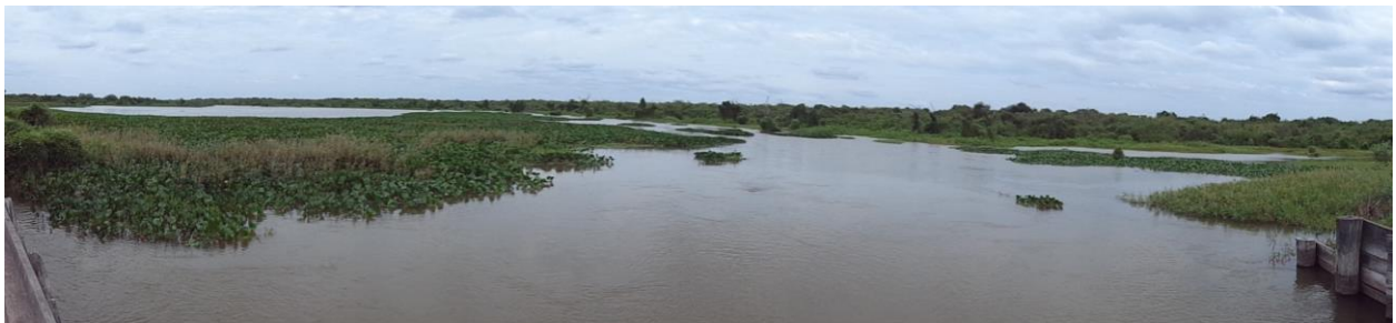
Foto 45. Gral. Díaz, aguas abajo del puente.
