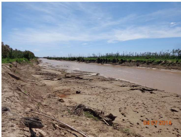
Foto 31. Aguas arriba – El Potrillo
