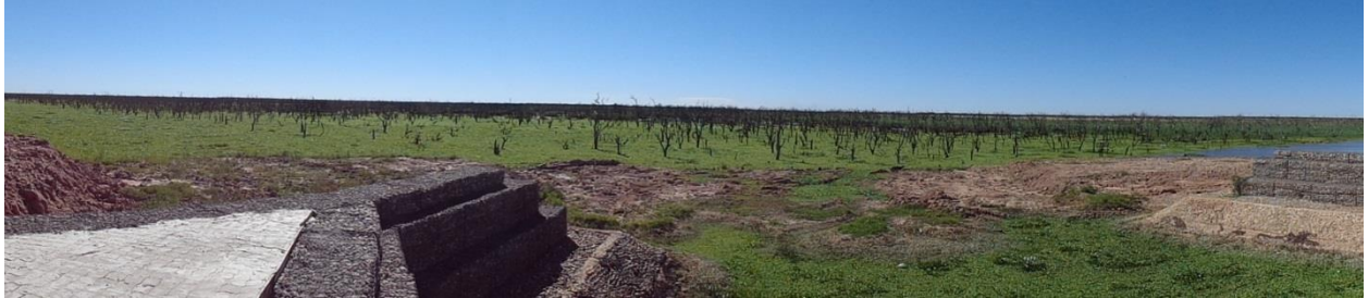
Foto 36. El Bañado La Estrella aguas arriba del vertedero
